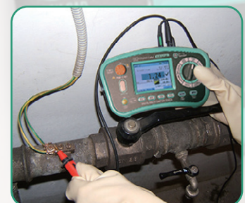
Continuity check of equipotential bonding
